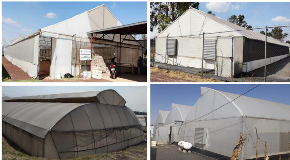
Estructuras de invernaderos usados en la agricultura protegida
