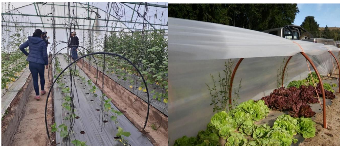
Vista interna y externa de un microtúnel como estructura de protección
